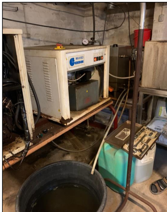
Foto 7 og 8 Foto fra virksomhedens kælderlokale: Kompressor og blødgøringsanlæg, samt dampkilde til strygerulle og dampstrygejern
