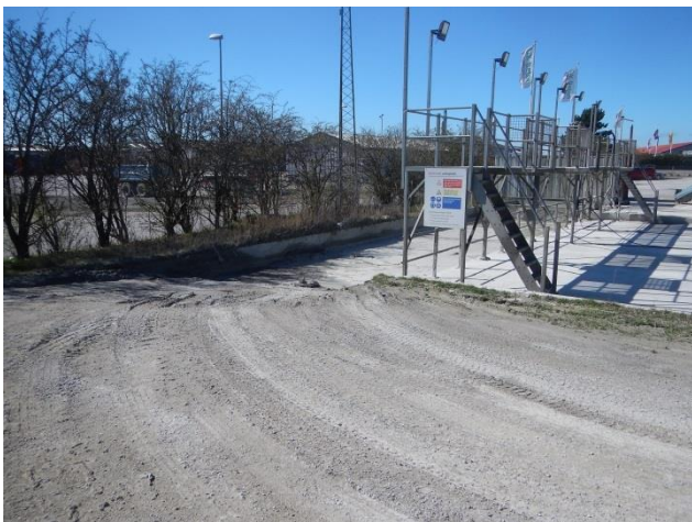
3. Frakørsel for tømning af sandfang
