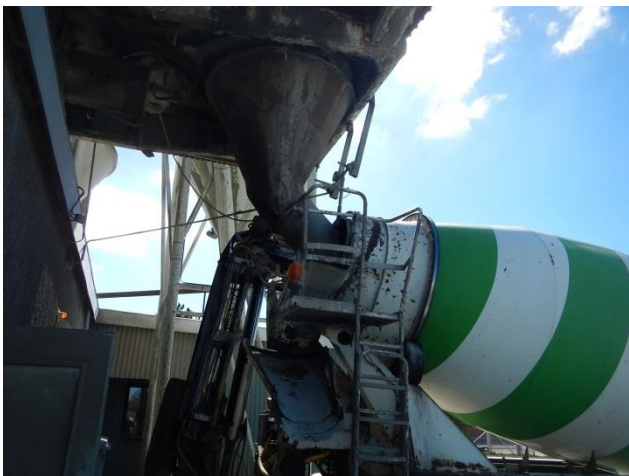
15. Udlevering af beton til betonlastvogn
