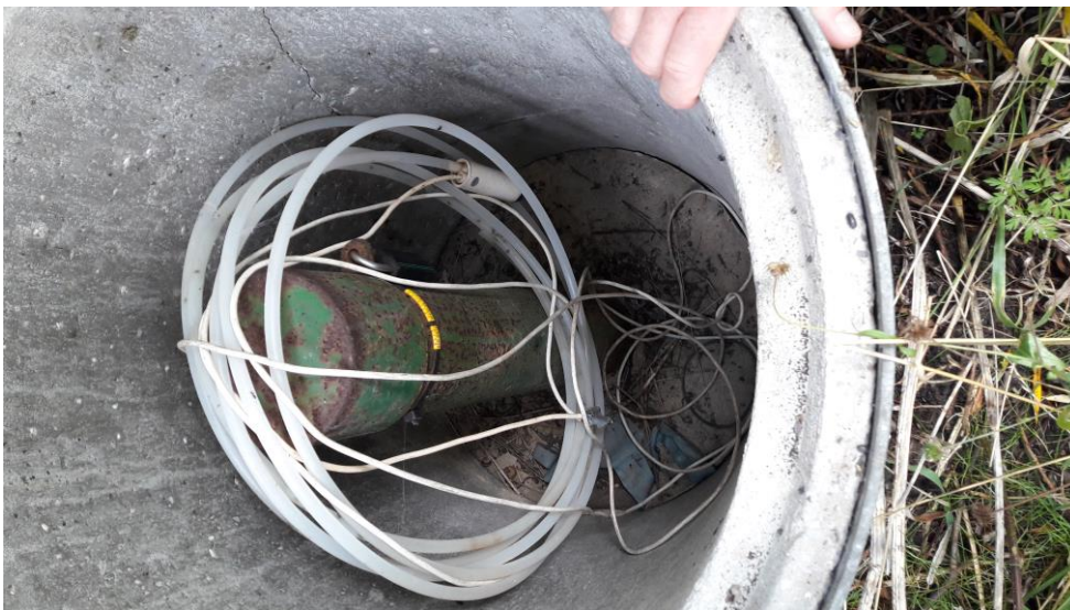
Boring afsluttet med "hat"-forsegling uden tætning
