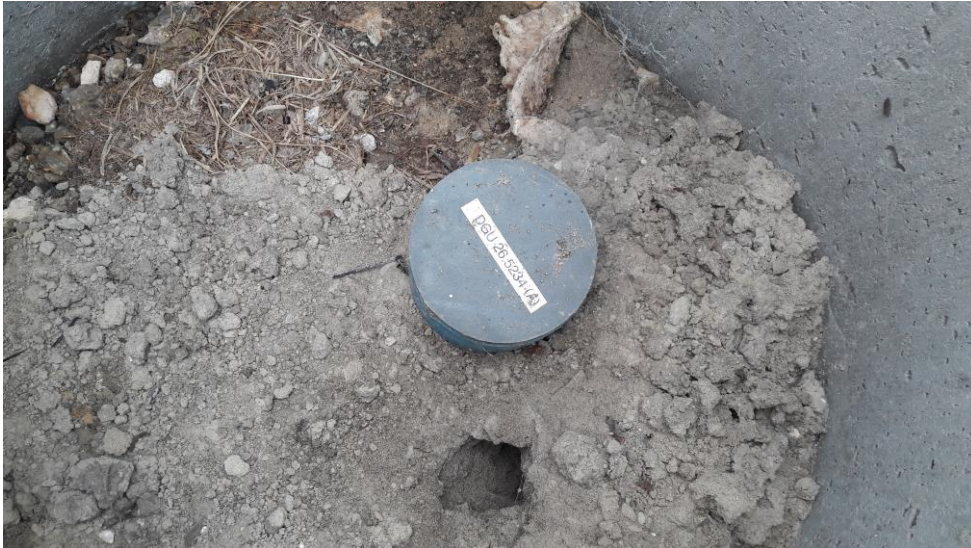
Næsten sandfyldt beskyttelsesbrønd
