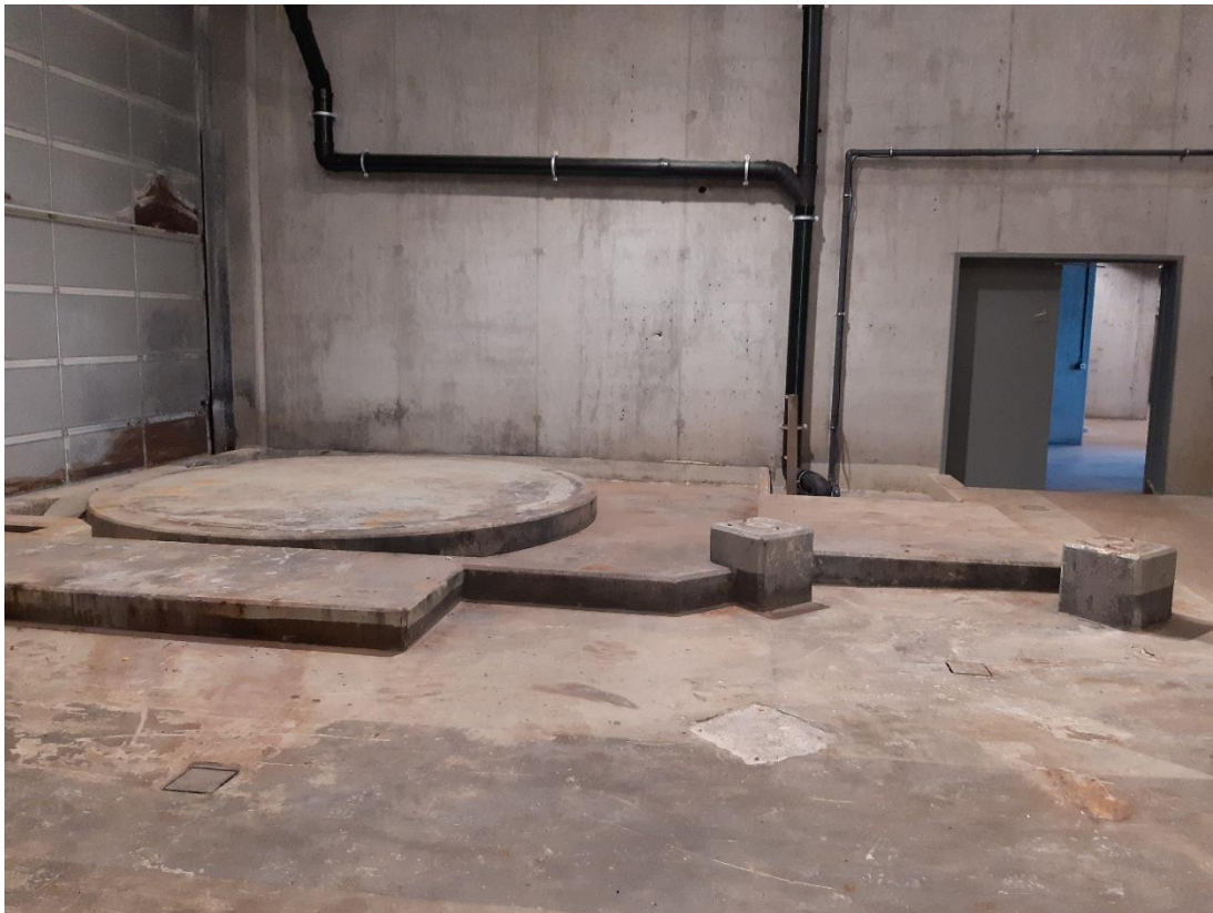
Foto 10. Spildevandsrensingsanlæg er fjernet.
