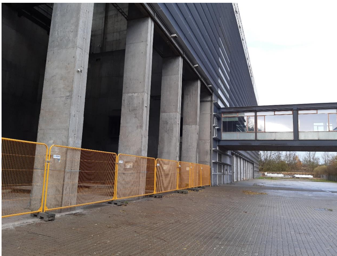
Foto 1. Modtagehallen er afspærret. Affaldssiloen er tømt og rengjort
