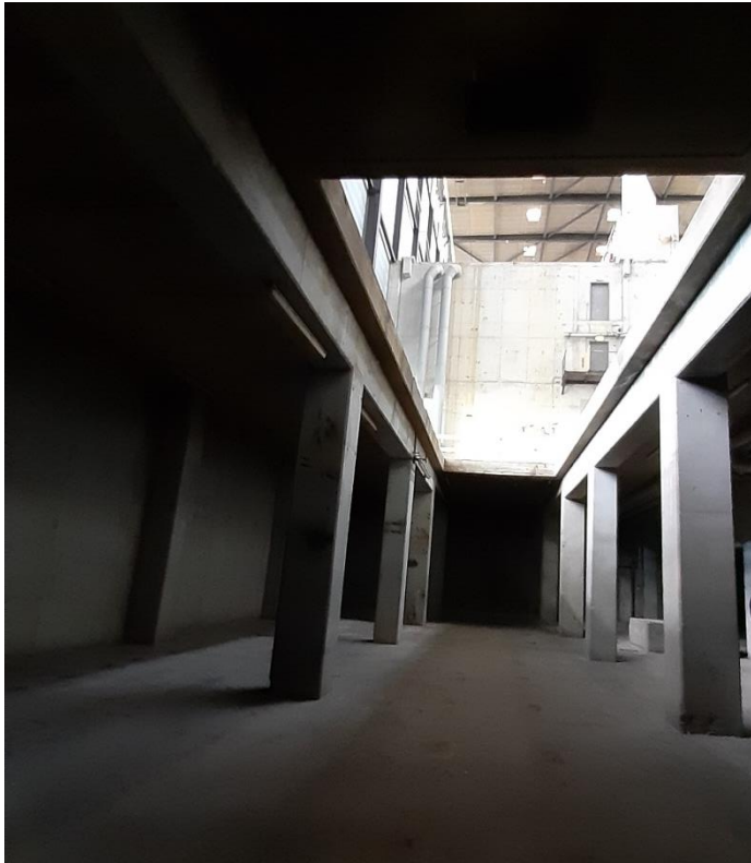
Foto 6. Bygning hvor forbrændingsanlægget har stået. Alt er fjernet.
