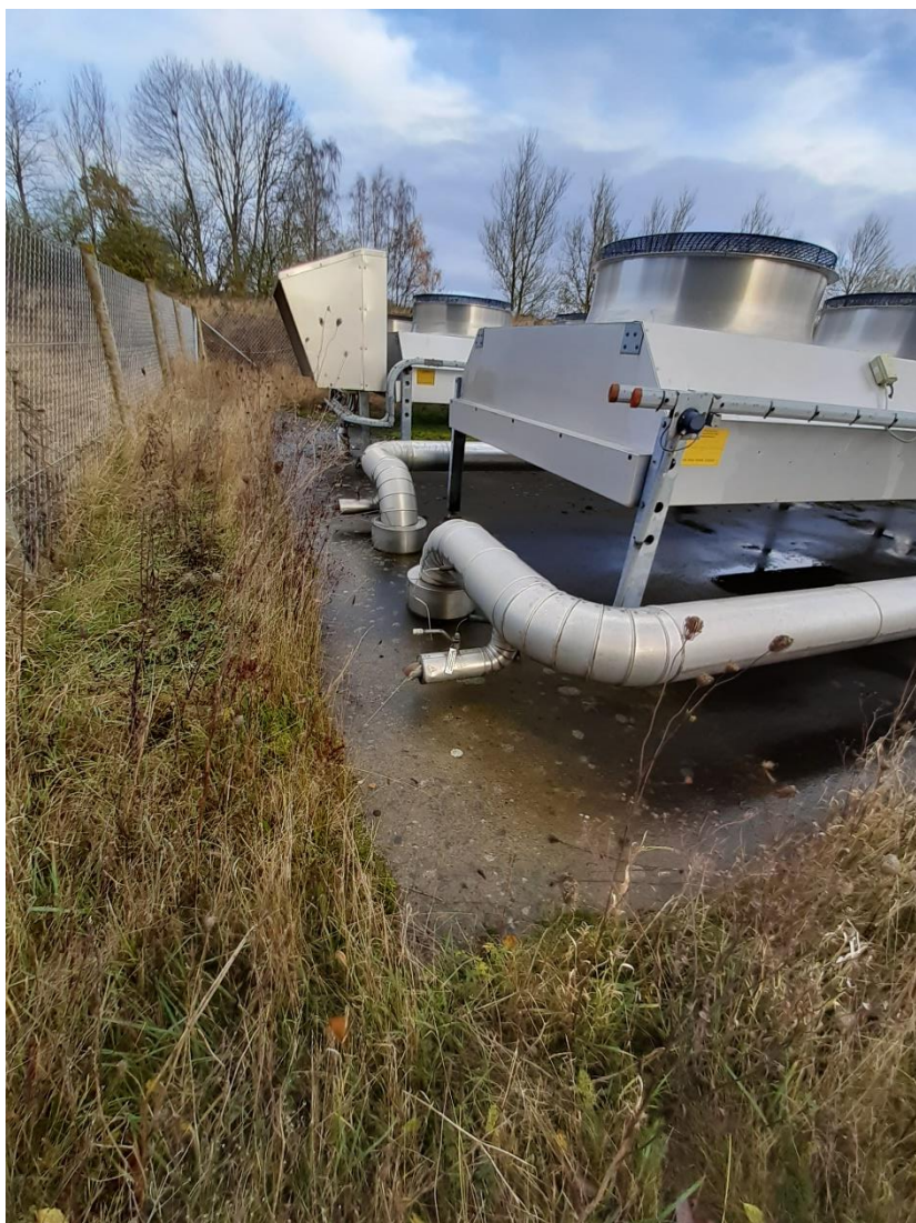
Foto 3. Køleanlæg var tømt for væske.
