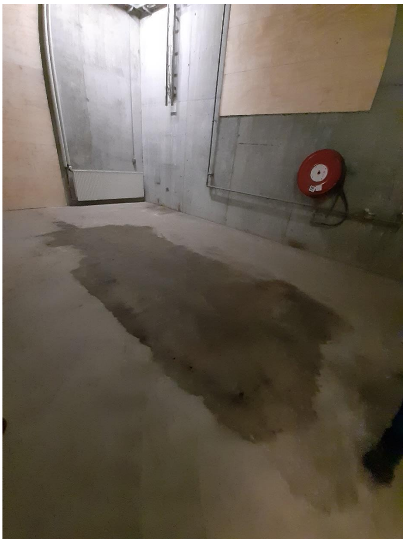
Foto 5. Rum hvor der tidligere var nødstrømsgenerator. Anlægget er pillet ned og fjernet.
