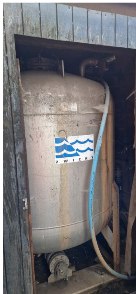
Aktiv kulfilter til intern spildevandsrensning
