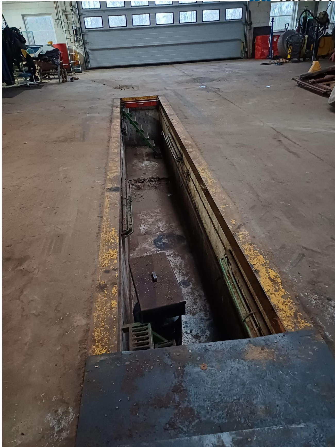
Værkstedet med grav til småreparationer.
