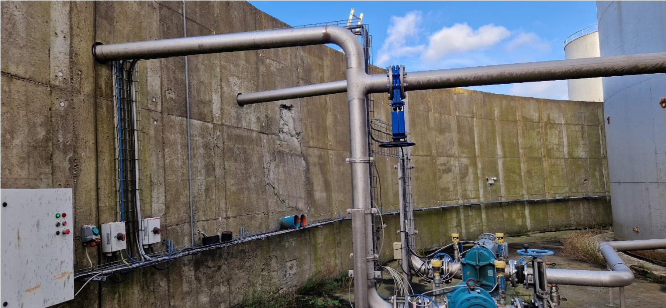
Tankgård 1. Ringmuren set indefra – der er påstøbt nyt beton indvendigt hele vejen rundt.
