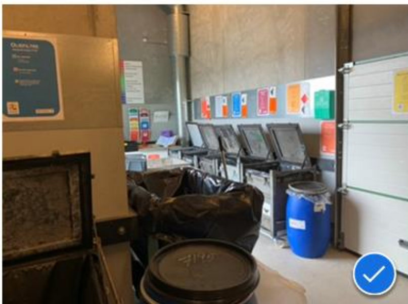
Foto fra modtagerrummet til farligt affald. Affaldet opbevares i lukkede beholdere.
