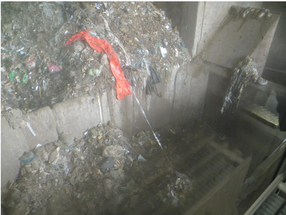
Foto 4 Udsyn fra kranfører aflæsningssilo
