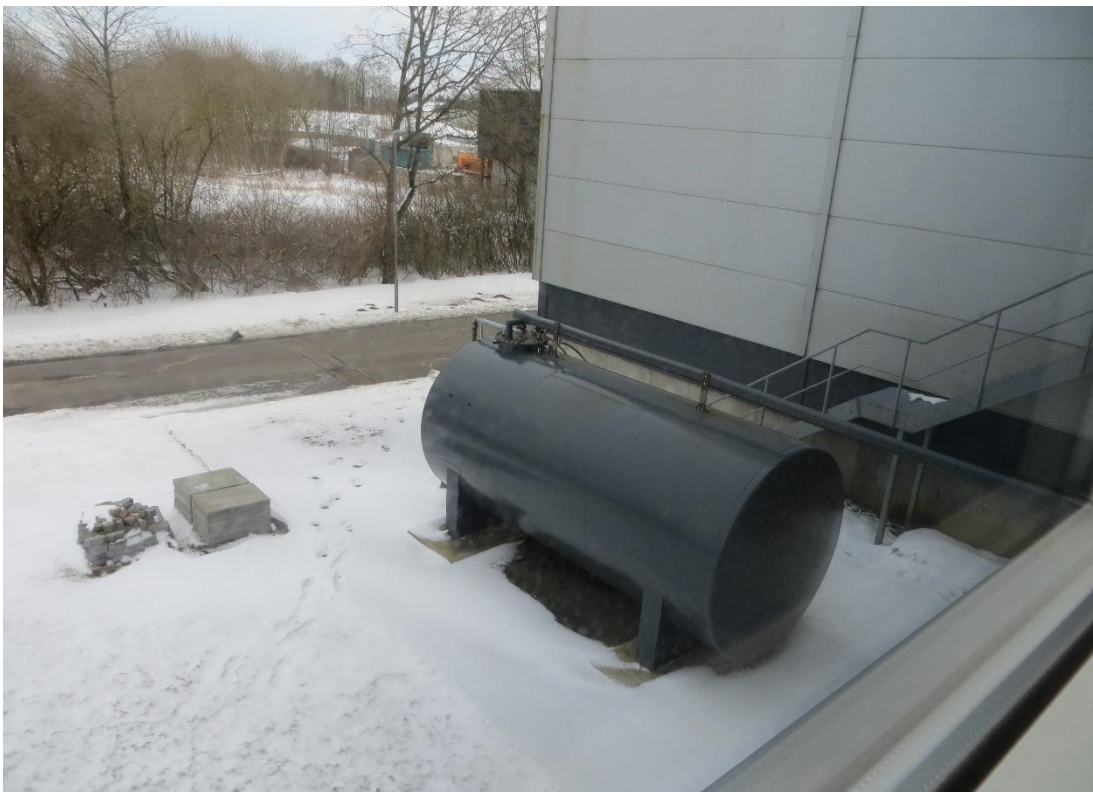
Foto 12 Olietank til støttebrænder
