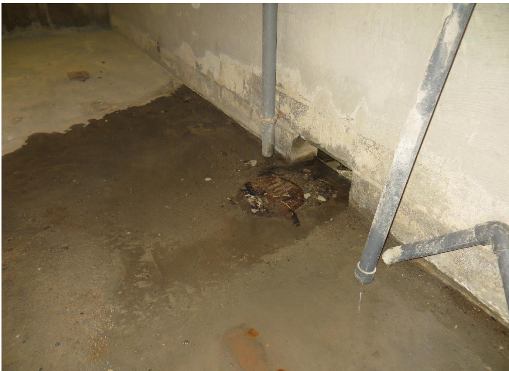
Foto 6 Afløb i slaggekælder Ovn 1
