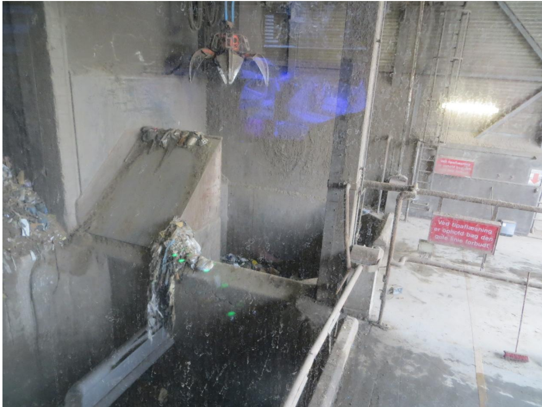
Foto 3 Udsyn fra kranfører, aflæsningsrampe
