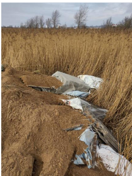
Figur 3 tv. enden af deponeringsfronten, hvor asbestplader på tilsynet den 18. december 2020 ligger synlige og knuste uden at være fuldt afdækket. Th. Del af den tidligere brede front, hvor der fortsat er synlige knuste asbestplader, som ikke er helt afdækket med jord.
