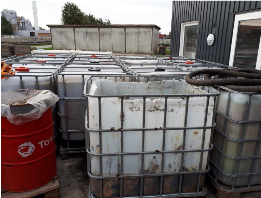
Oplag udendørs af affald/kemikalier på den tætte belægning ikke sikret mod påkørsel.
