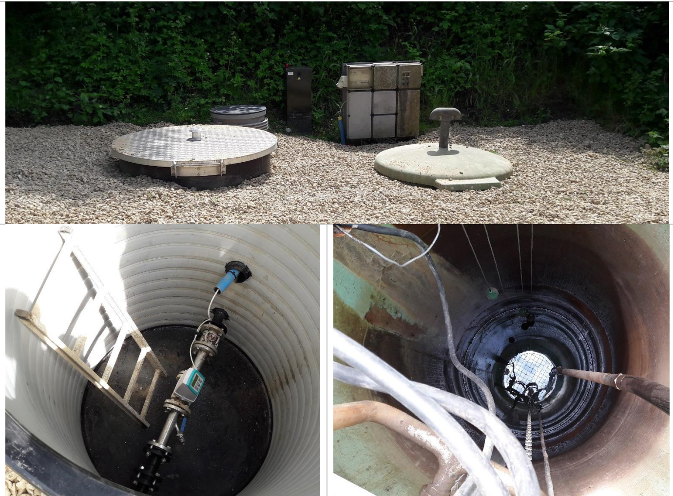
Figur 3: Samlebrønd th og ny brønd til flowmåler tv.
