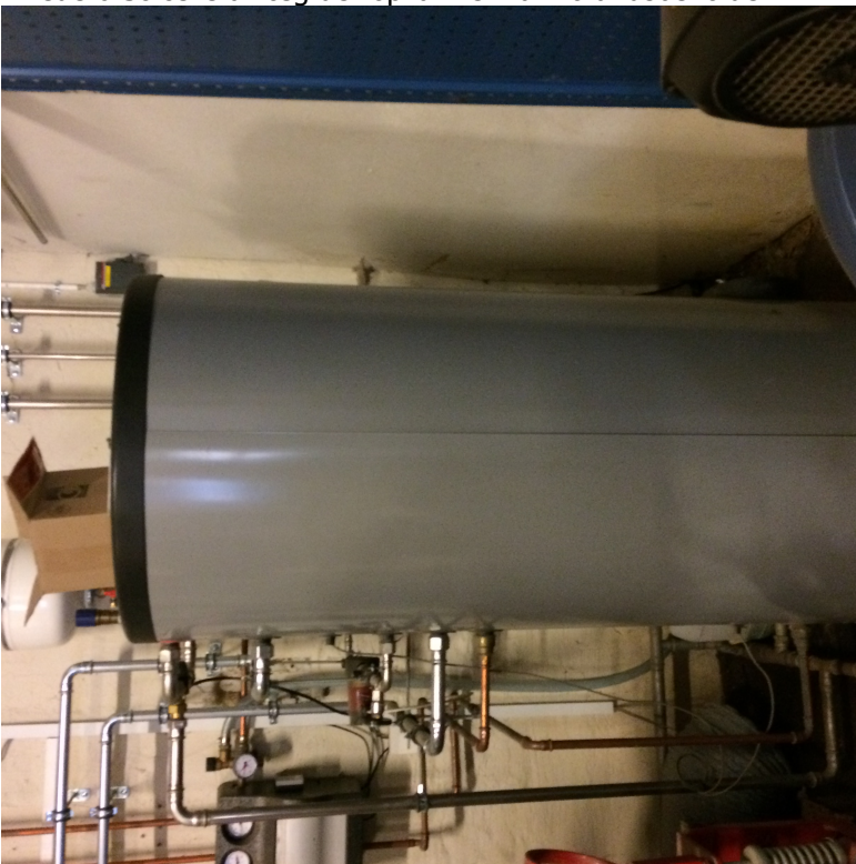
Billede 6 Solcelle anlæg der opvarmer varmtvandsbeholder
