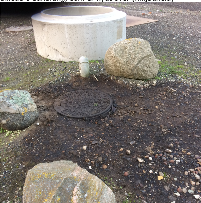
Billede 8 Sandfang, som er flydt over (miljøuheld)
