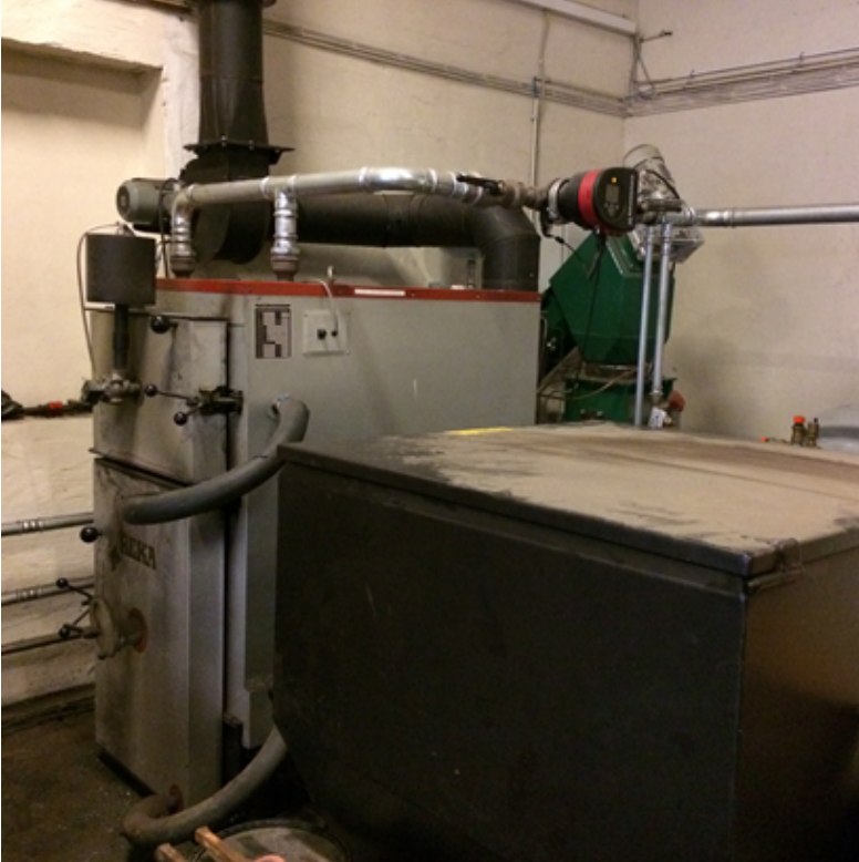
Billede 5 Kornfyringsanlæg
