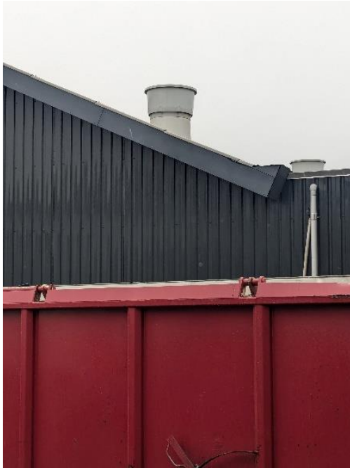
Billede 2: Tagryggen af den nye stald med de afkast, der er etableret.
