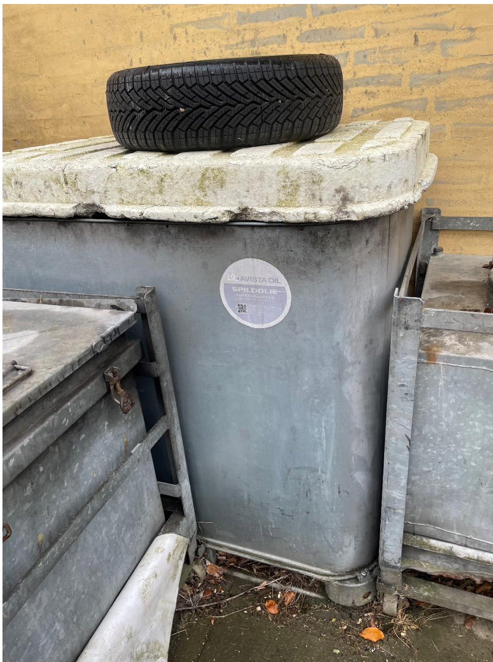
Billede 6. Virksomhedens udendørs dobbeltvæggede tank med spildolie.
