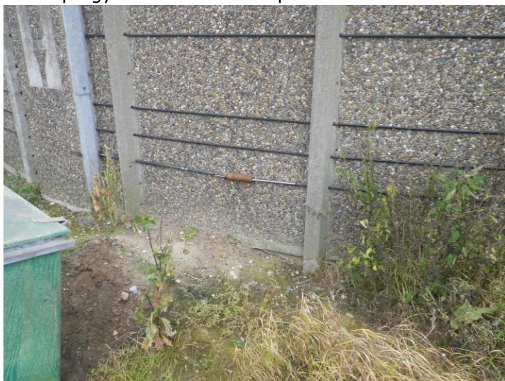
Billede 1: Kabel repareret.
