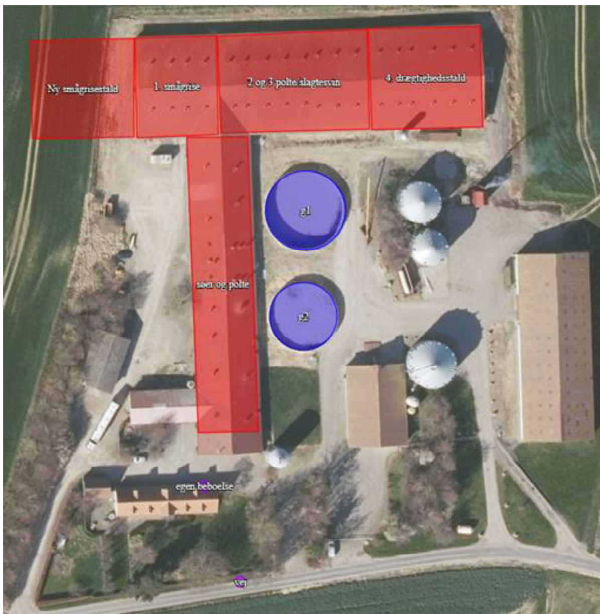
Gyllebeholder nr. 2 skal overdækkes
