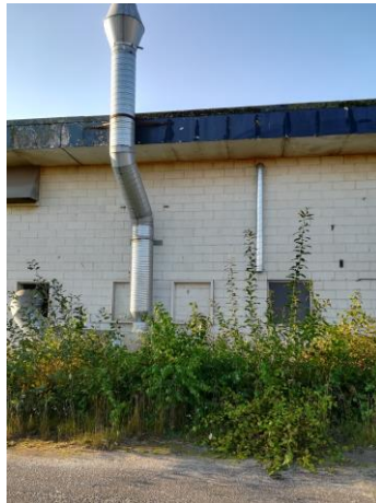
Afkastet til venstre er fra glasblæsningen og det lille til højre er fra kompressoren
