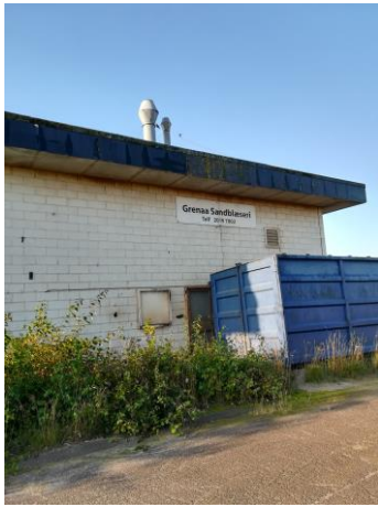
2 afkast fra stål/sandblæsning samt container til affald fra sand-, stål- og glasblæsning
