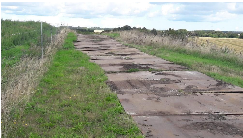
Areal på den nedlukkede etape I, celle 1-b til biocover-vindue i form af lang smal rende. Køreplader fjernes i takt med arbejdets fremdrift fra fjerneste ende.
