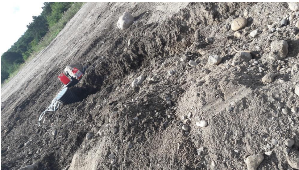
Vest for gashuset er brønd til tilbageholdelse og afledning af eventuel kondensat fra det indvundne gas.
