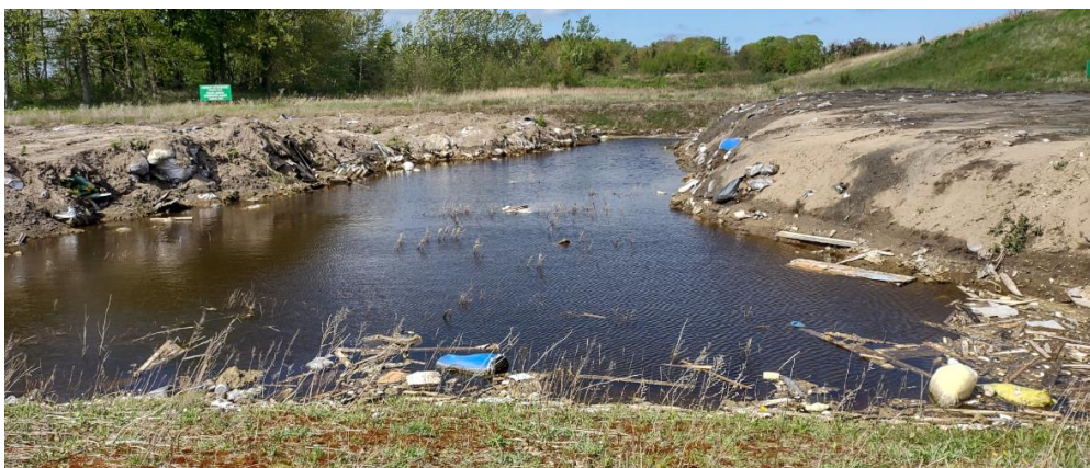
Billede 10. Opstuvning af perkolat i deponiet.
