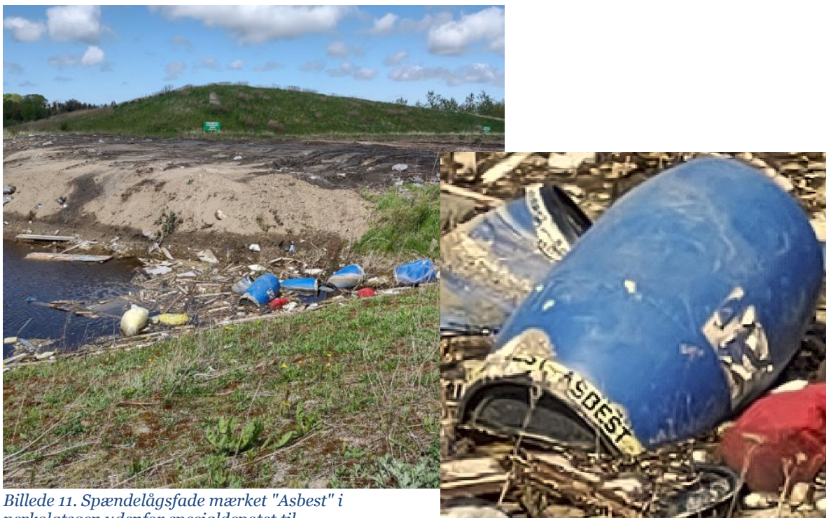
Billede 10. Opstuvning af perkolat i deponiet.
