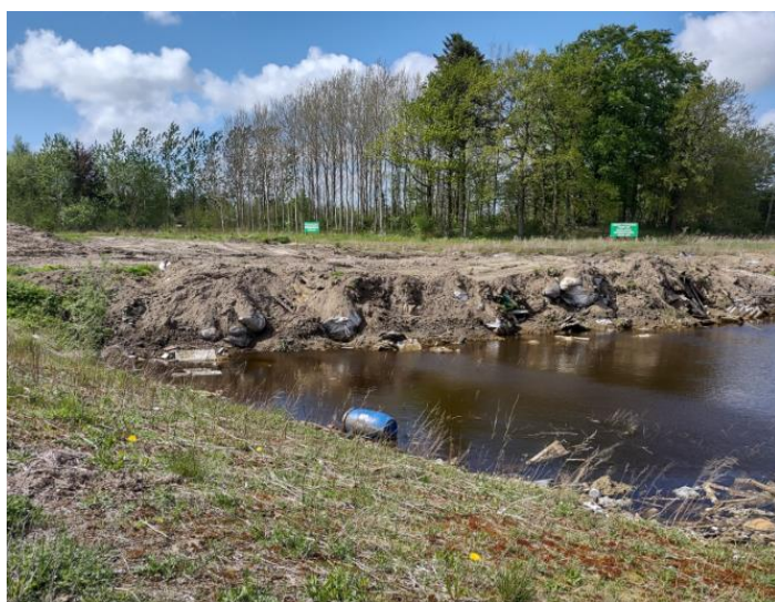
Billede 3. Specialdepoterne er skiltet, PCB-holdigt til venstre og asbest til højre. Der er ikke nogen tydelig afgrænsning imellem cellerne.
