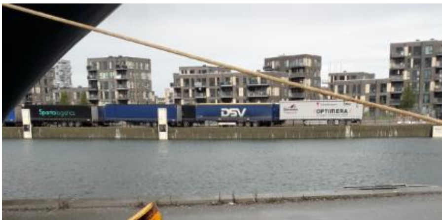
Foto: Spunsen på område B (Nordre Leje) beklædt med beton.
