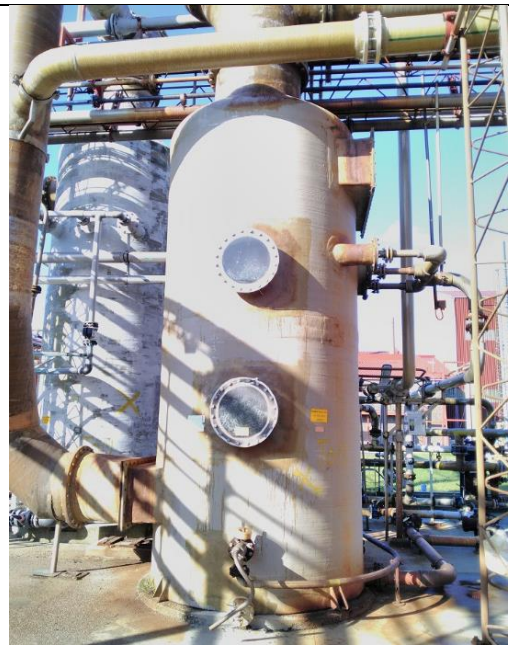
Figur 9. Basisk skrubber 2 på Norit- og P2-området.
