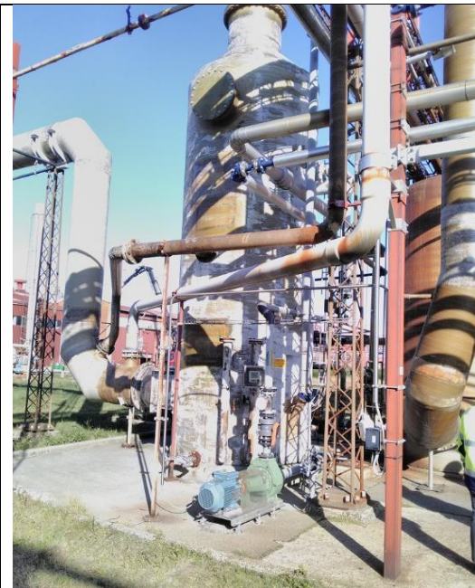
Figur 8. Basisk skrubber 1 på Norit- og P2-området.
