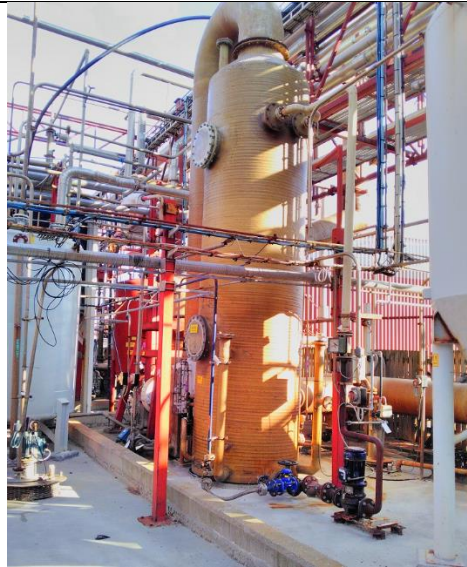
Figur 2. Basisk skrubber ved DMT- og forsøgsanlæg.
