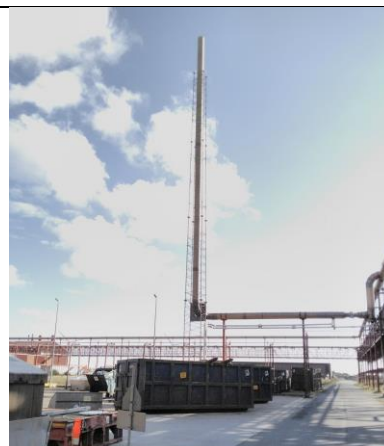
Figur 4. Nødskorsten ved dampplads.
