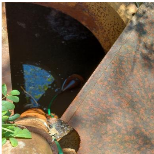
Tank 1 åbning i toppen ved tankens forsiden. Tanken næsten fyldt
