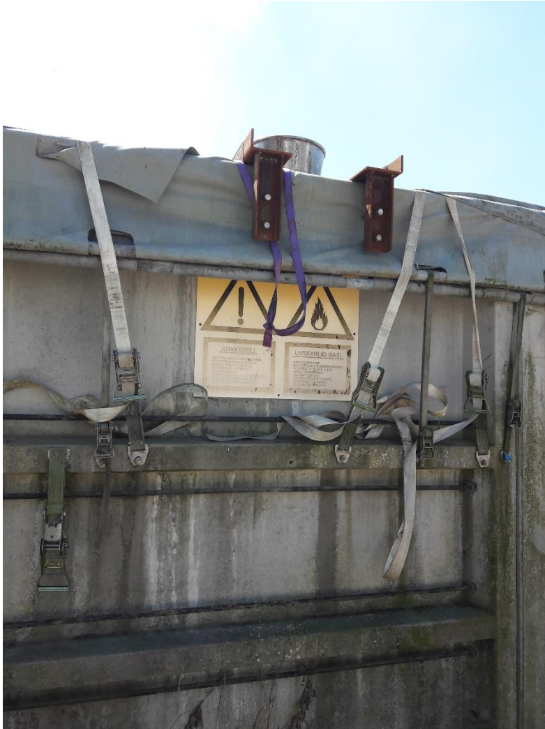
Beholder med påfyldningsrør
