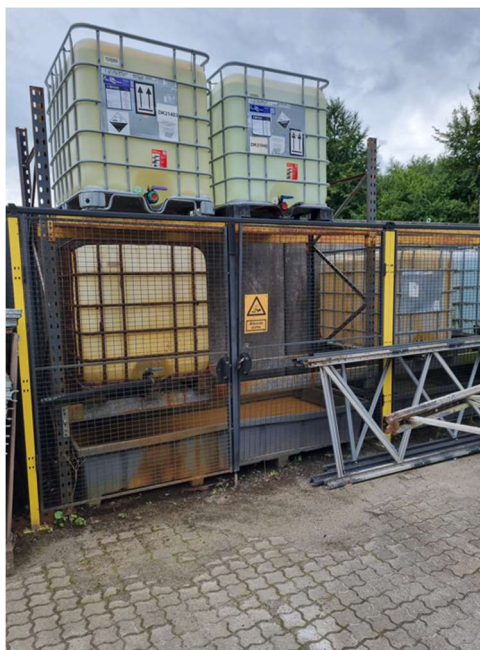
Spildbakke under tanke med 30 % HCL
