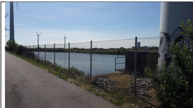
1. Aflåseligt hegn på dæmningen omkransende lagunen og deponiet. Taget mod sydøst.
