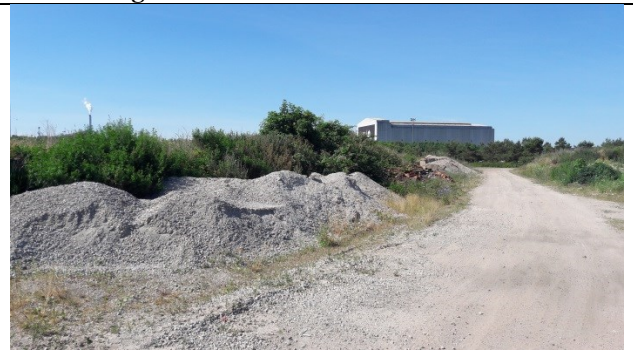
6. Bunker med uforurenede fraktioner (til afdækning og køreveje) langs vejen til tipfronten. Mod SV.
