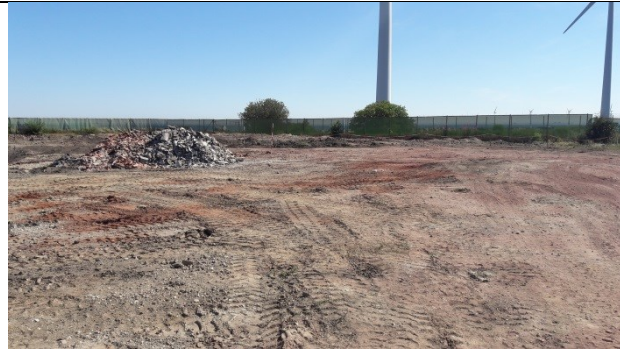
7. Taget ved tipfronten mod det NØ-lige hjørne med støvafskræmning på hegnet. Bunke af tagplader/brokker til afdækning og køreveje.
