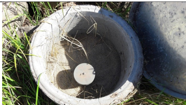
14. B2 med aflukket rør (DGU nr. 201.7450)
