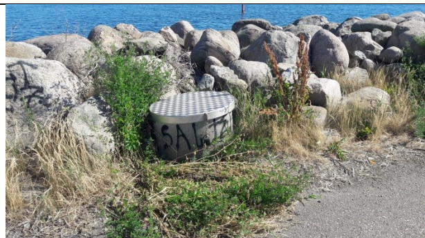
11. B1 med aflåst beskyttelsesbrønd (DGU nr. 201.7449)
