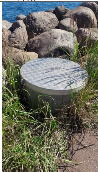
13. B2 med aflåst beskyttelsesbrønd (DGU nr. 201.7450)
