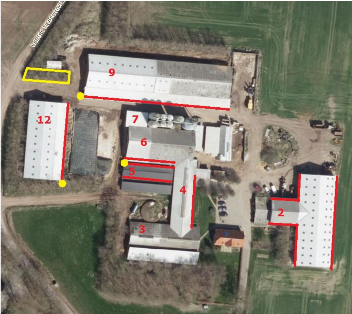
Figur 5. Tagvand på eksisterende bygninger.
