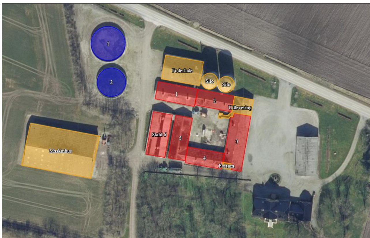
Figur 1: Driftsbygningerne på Tøttrupvej 8. Nederst til venstre ses stuehus og garage.
