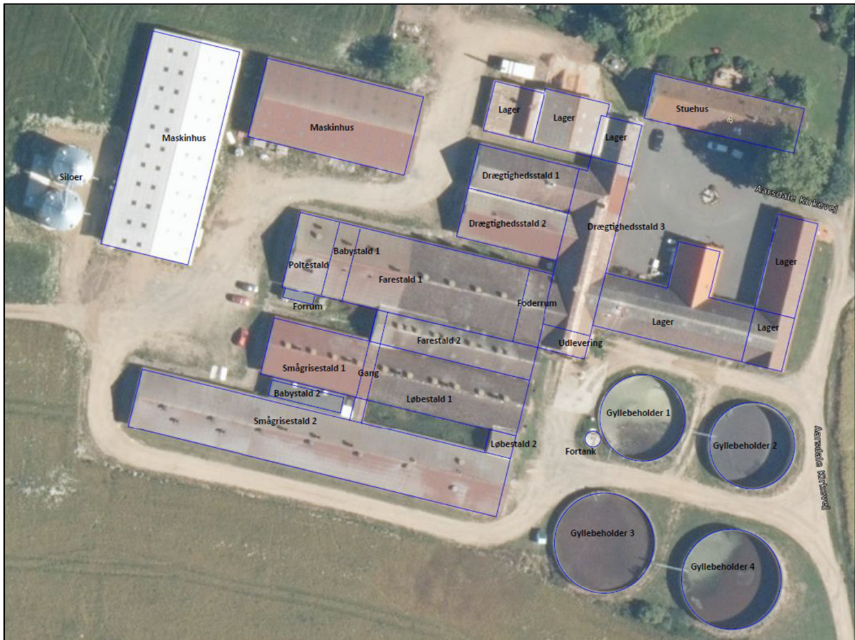
Figur 4 Anlægget på Skovsholm
