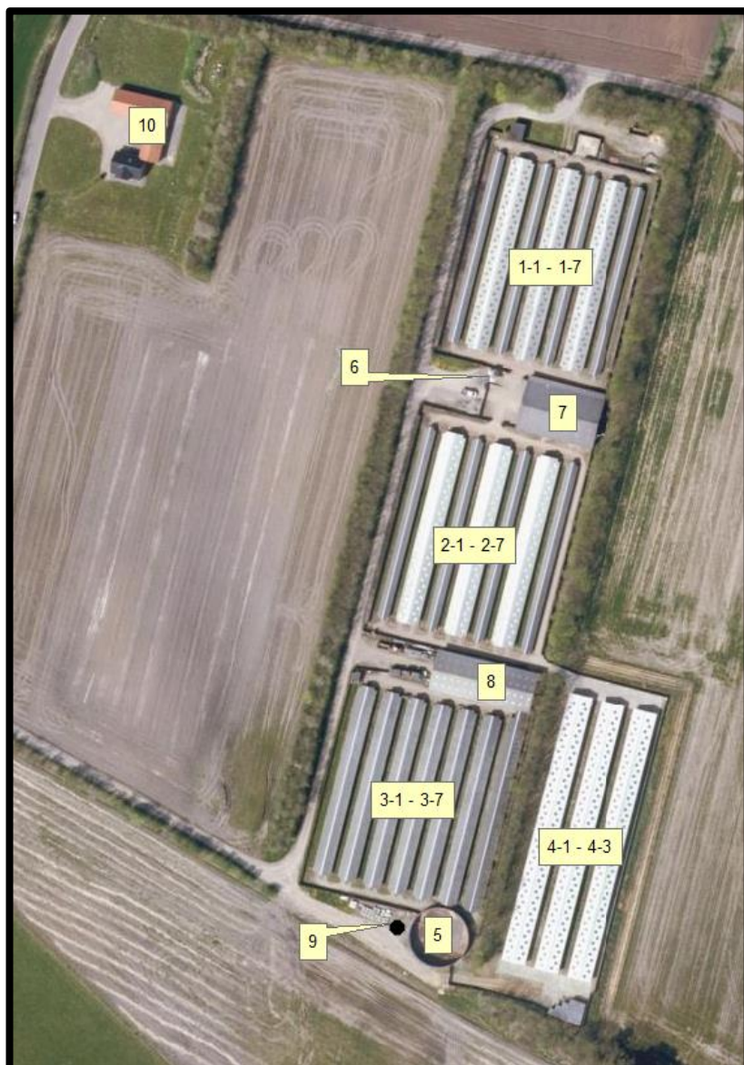
Figur 6. Oversigt over minkgårdens bygninger.
