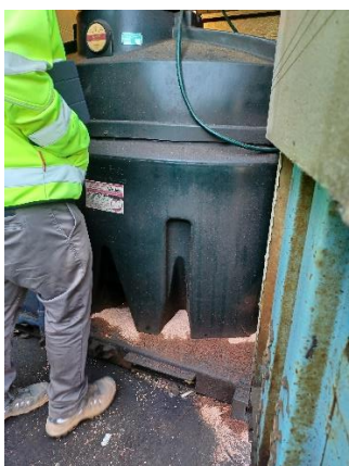
Spildolietank ved køleskabshredder, hvor der har være spild.
