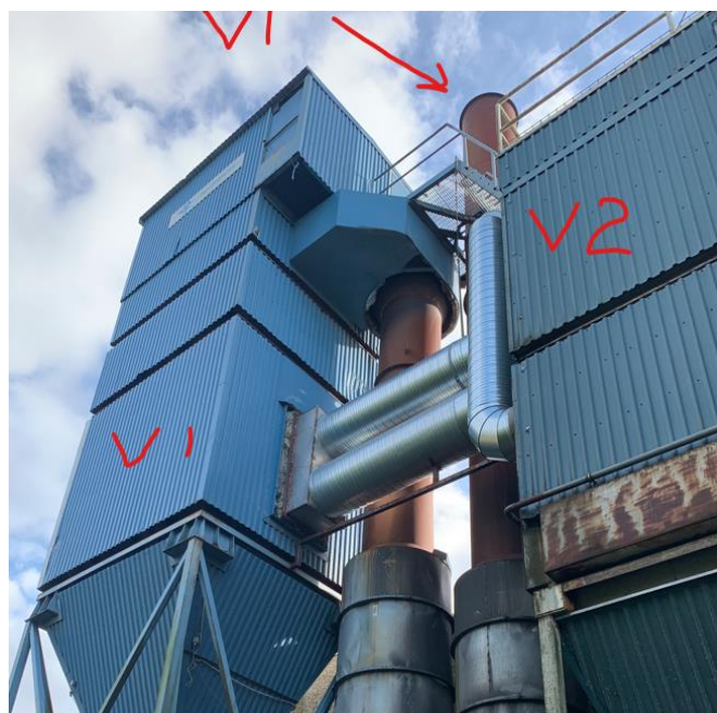
Billede 2: Afkast med filter og med indtegning af filter V1 og V2 (billedet er taget af virksomheden)
