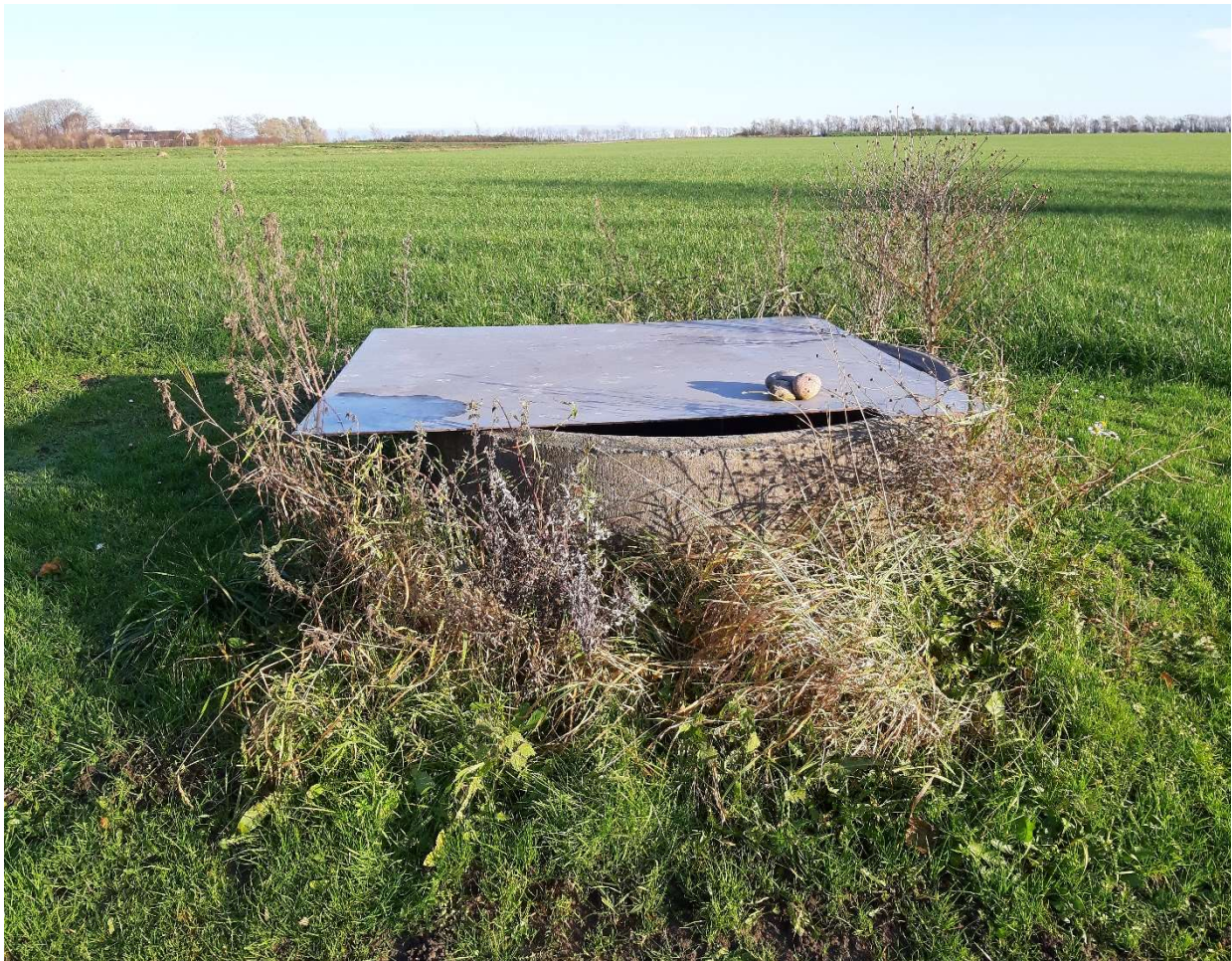
Figur 2 – Vandboring set fra indkørslen. Billedet er taget i østlig retning.
