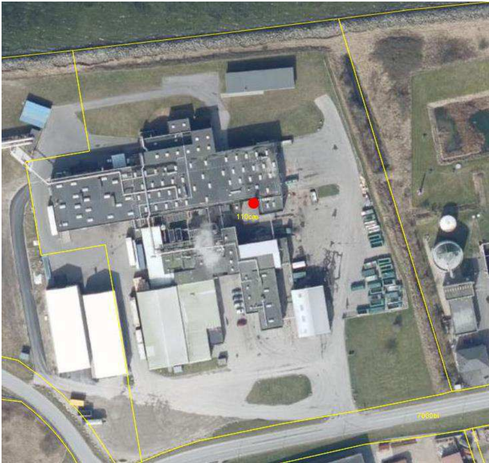
Figur 3.1 Placering af afkast fra kedler ved den røde prik. Gule linjer er skelgrænser mellem matrikler. Korteste afstand til skel er 63 m mod øst.
