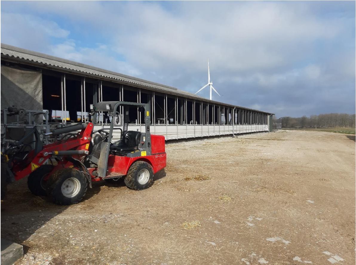
Foto 1. Der opføres nyt staldareal i forlængelse af den eksisterende kostald.
