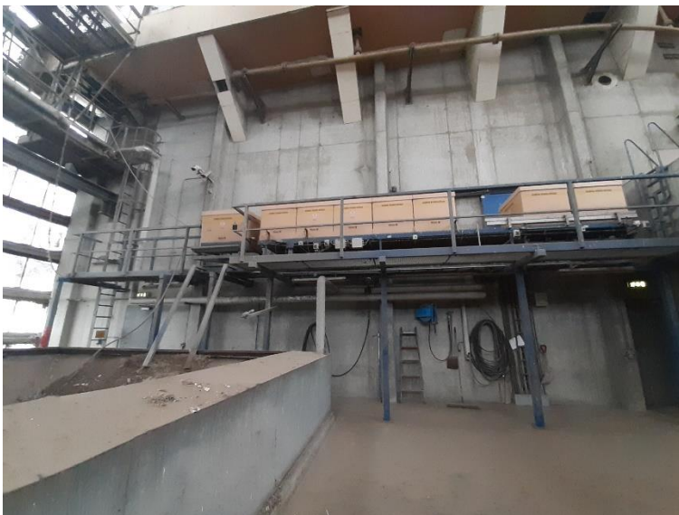
Foto 5. Transportbåndet leverer klinisk risikoaffald til indfyring.
