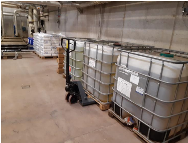
Foto 2: Opbevaring af kemikalier i pallettanke. På fotoet ses også gulvafløb.
