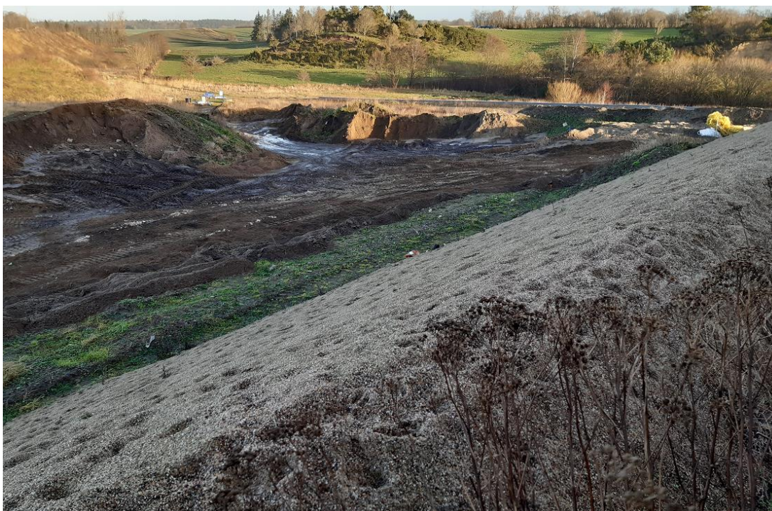
Billede 2. Udsigt fra skråningen af enhed 1 ned over S1/S3, enheder for asbest.
