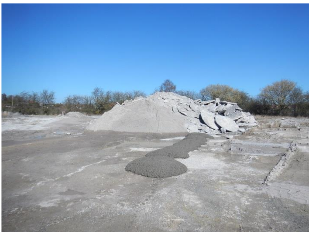
5. Oplag af hærdet betonaffald + lidt lagt til hærkning
