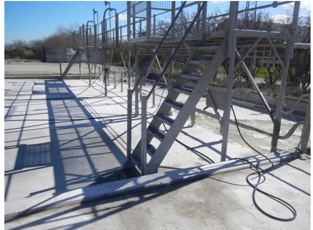
2. Vaskeplads for beton-lastvogne
