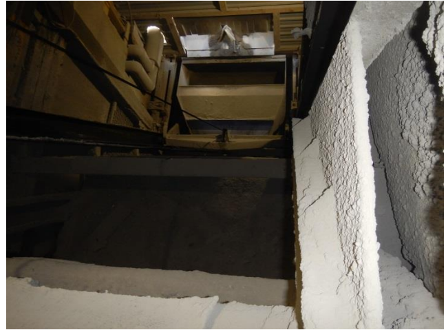
32. Samme som 31. I skakten løftes færdigblandet beton fra blandedanlægget i "skovl" (der kører på skinner) til udleveringstrakt -se udlevering foto 15.
