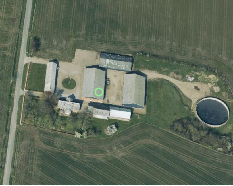
Skråfoto set fra syd af den eksisterende bygningsmasse.
