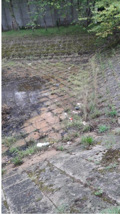
Figur 1 Perkolatbassinet. Bassinet er udført med fliser med en membran nedenunder. Der var ikke vand i bassinet under tilsynet.
