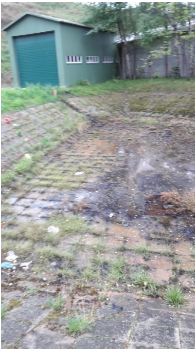
Figur 1 Perkolatbassinet. Bassinet er udført med fliser med en membran nedenunder. Der var ikke vand i bassinet under tilsynet.
