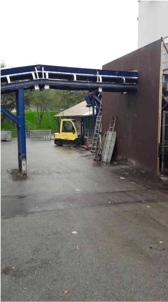
Figur 19 Ny støjskærm sat omkring transportbåndet for at nedbringe støjbelastningen fra anlægget.
