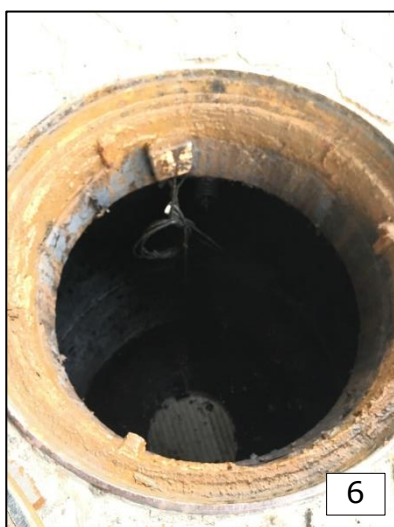
Foto 6-8 af olieudskillerbrønd med føler fra tilsynet
