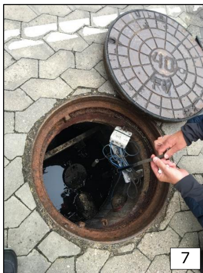
Foto 6-8 af olieudskillerbrønd med føler fra tilsynet
