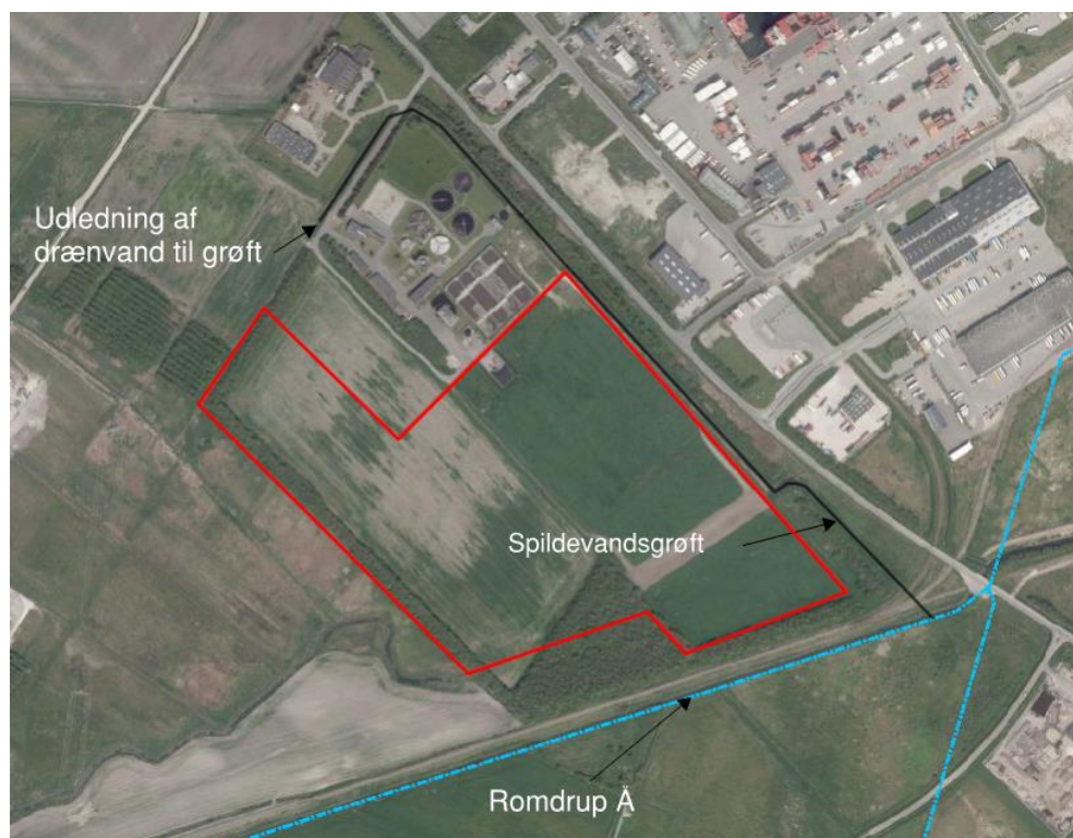
Figur 6-1: Placering af udledningssted for drænvand til spildevandsgrøft. På figuren er med rødt vist det område som AFK fremadrettet ønsker at anvende til udlægning af sand og slam. Grundkort: copyright ©Geodatastyrelsen Ortofoto: DDO ©land 2012 ©COWI
