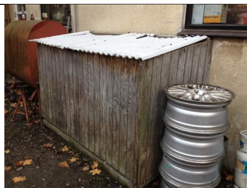
Foto 2 overdækning af kompressor
