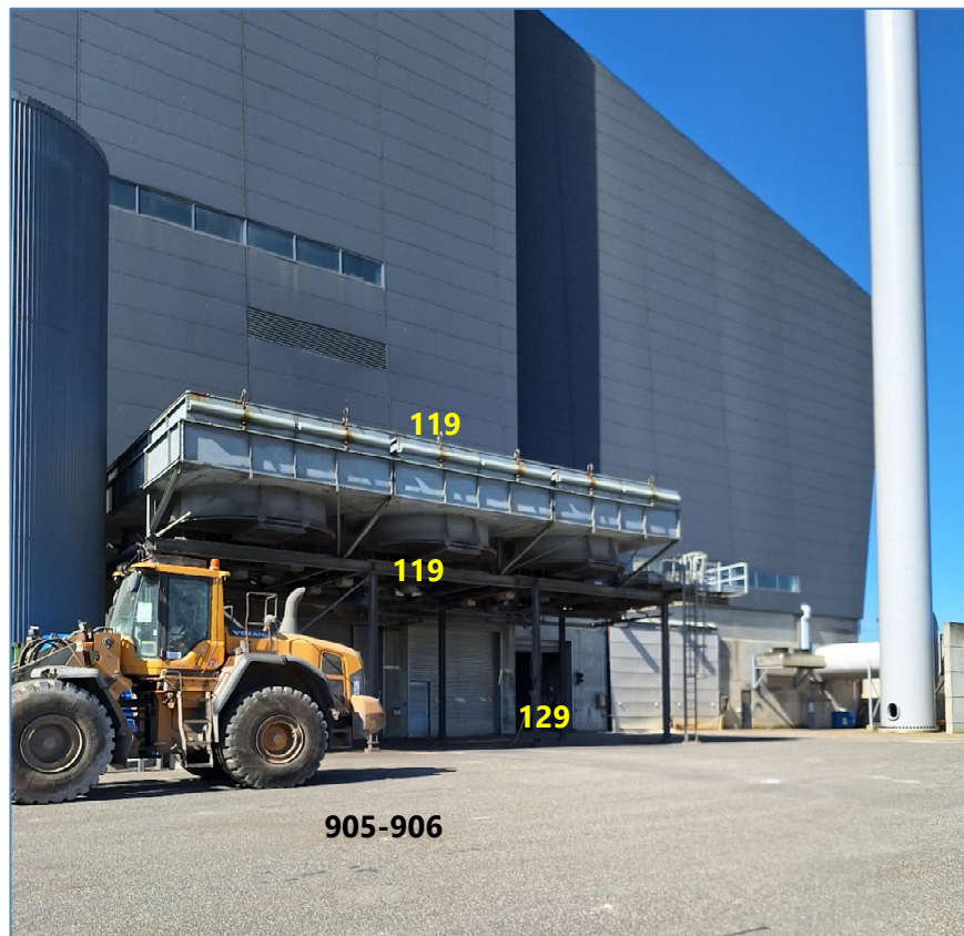
Billede 4. Kilde 119 er målt i stor afstand for at få støj fra overside og underside i én måling. Den ene gummihjulslæsser, kilderne 905 og 906 samt porten 129.
