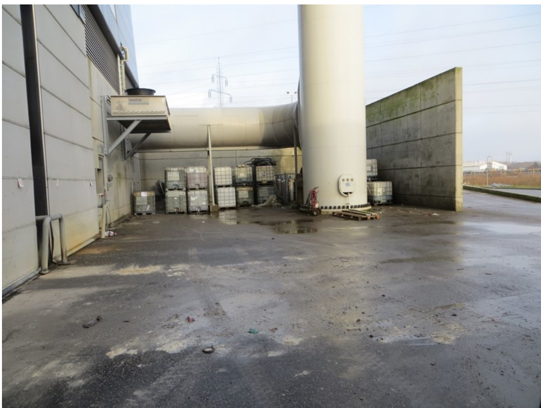
Asfalt udenfor udlevering af filterkage nærmest og ristegennemfald. Oplag af kemikalier bagerst. Pladsen afvandes via olie- og benzinudskiller til det interne rensningsanlæg. Billede taget ved Miljøstyrelsens tilsyn 8. december 2016
