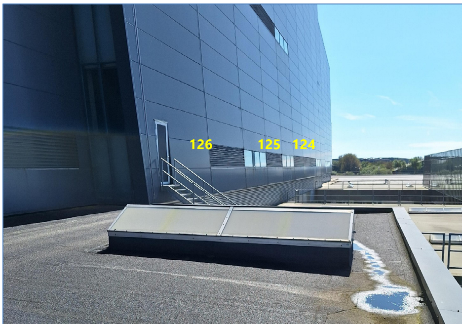
Billede 9. Kilderne 124 til 126, de mørke bånd (2 korte, 1 langt) er passive udluftninger.
