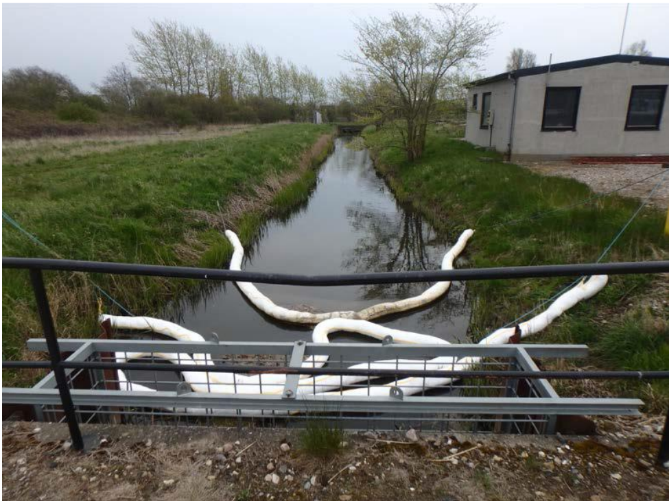
Flydespærring udlagt i Sildebæksrenden.
