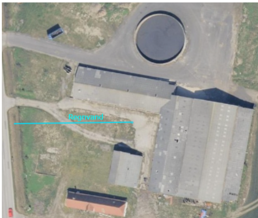
Figur 3: regnvandsledning der skal sløjfes før etablering af gyllebeholder
