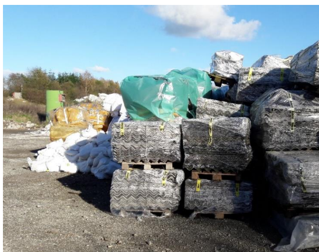
Figur 1. Deponering af affald på etape 6. 1) Tippen. 2) Indpakkede asbestplader. 3) Delvist afdækket asbest.
