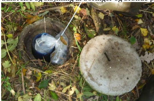
Foto 6: Boringen som efter RAØ's ønske skal indgå i et kommende grundvandsmoniteringsprogram.
