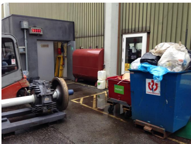
Miljøgård 8: Fyringsolietank til maleværksted.
