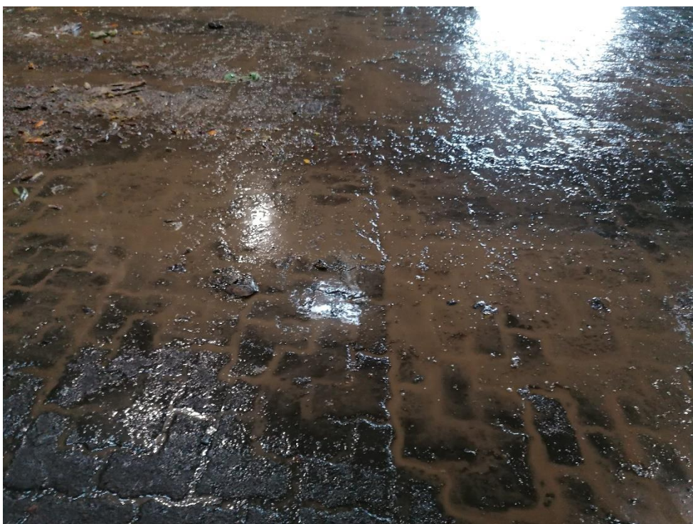
Belægningen lige uden for båsen. Vaskevandet og perkolat fra KOD-affaldet var stillestående og kun meget svagt afløb mod rist. Belægningen var klistret af affald.
